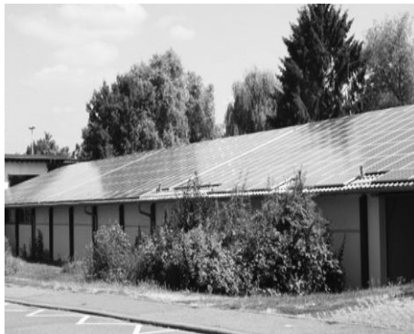
Die Bürgersolaranlage auf dem Dach des Aquadroms.
