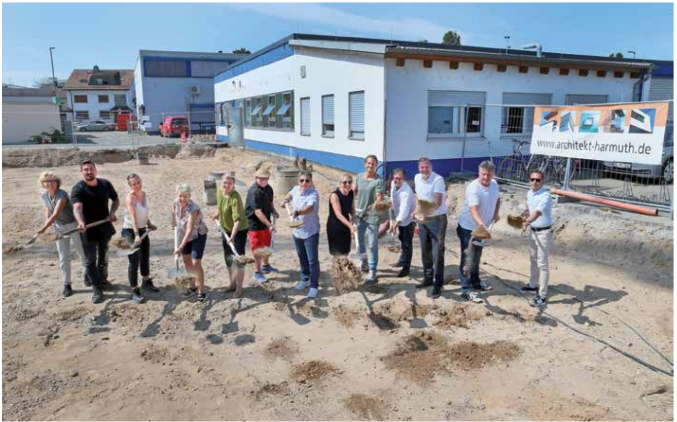
Die Erde fliegt: Mit dem Spatenstich am Bauhof beginnen die umfassenden Neubau- und Sanierungsmaßnahmen.
