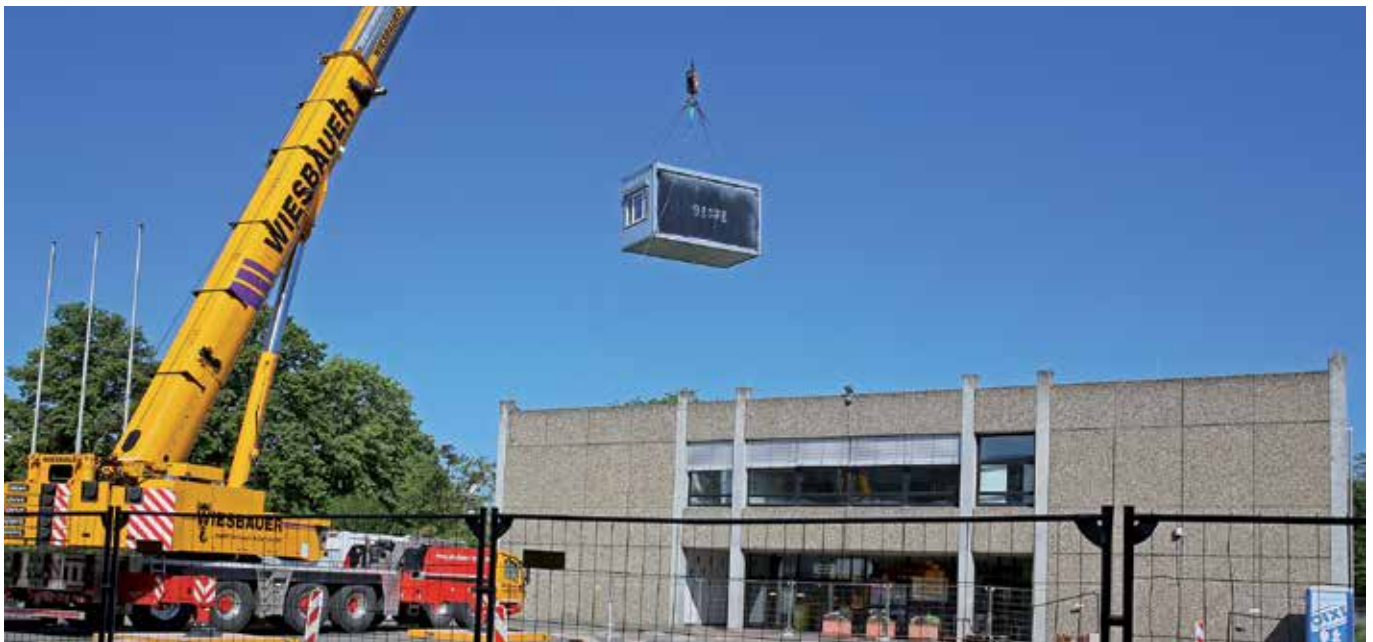
Die gelieferten Container werden im Schulzentrum als provisorische Unterrichtsräume genutzt.
