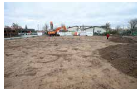
An dieser Stelle im Quartier Auchergrund entsteht das neue DRK-Gebäude.
