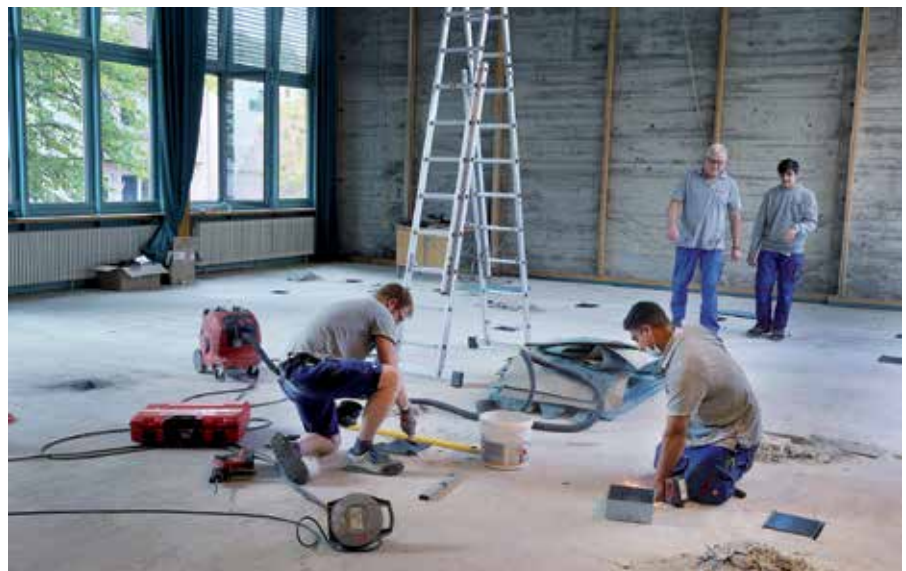
Anbringung der Bodentank-Elemente, durch die die Kabel von den späteren Sitzungstischen „unsichtbar“ weggeführt werden.
