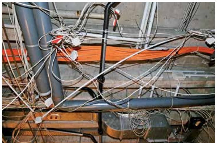
Blick hinter die Decke im Gauß-Gymnasium.
