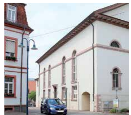
Nadelöhr mit viel Verkehr: Eine Baumaßnahme der Stadt Hockenheim erhöht die Verkehrssicherheit an der Einmündung Untere Mühlstraße/Oberer Hauptstraße.
