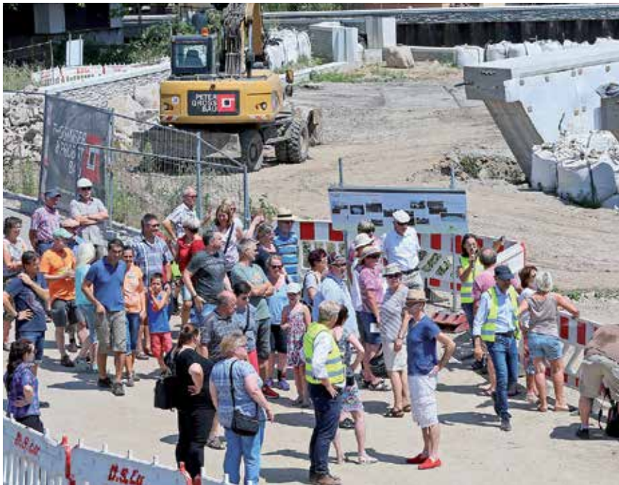
Zahlreiche Besucher erkundeten bei strahlendem Sonnenschein die offene HÖP-Baustelle.
